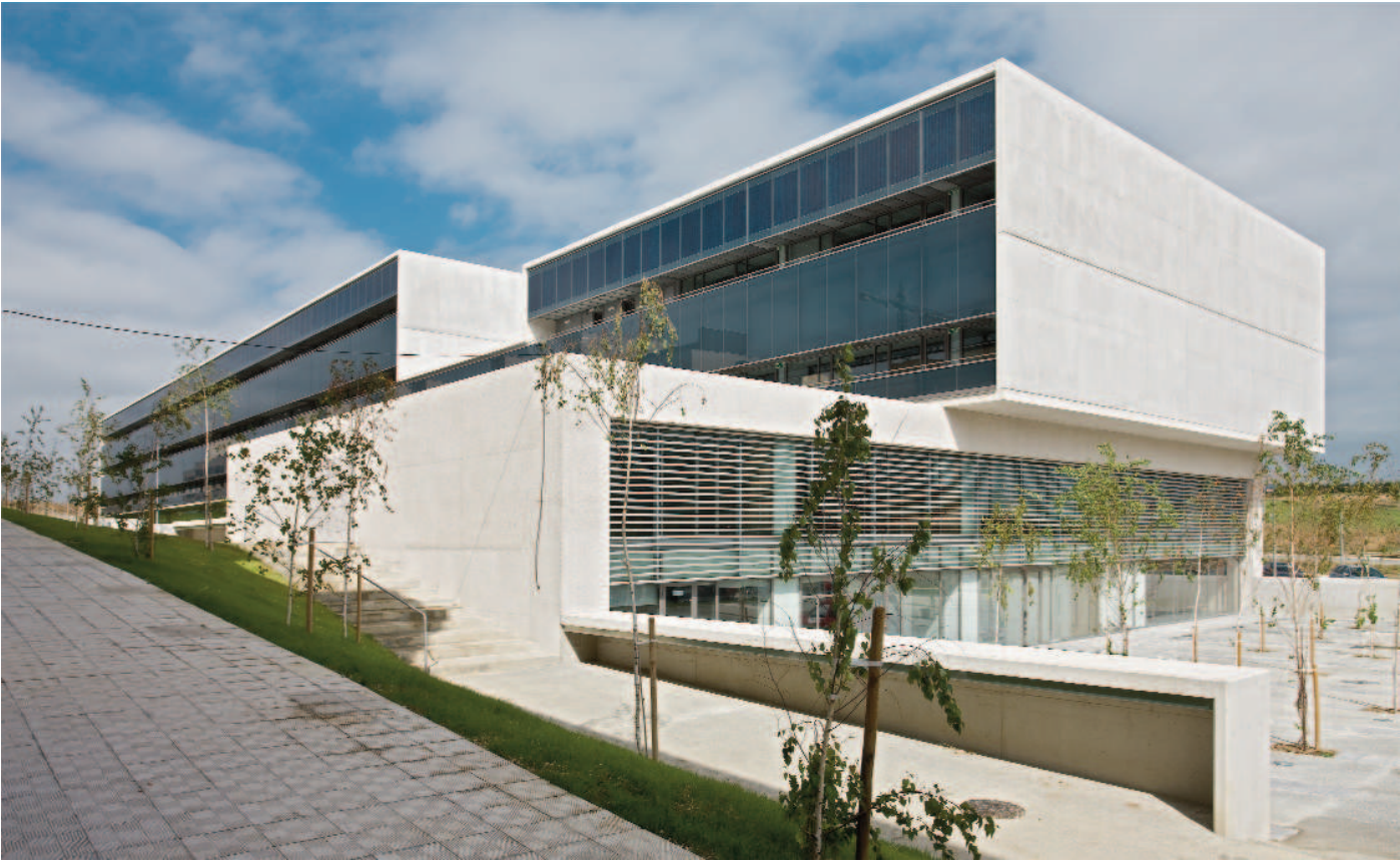
left Office Building VallRufea, Lérida (Spain); above Office building for Tracasa, Navarre(Spain) / NAN 2009 Awards to the best energy efficiency integration in architecture, first prize izquierda Edificio de Oficinas VallRufea, Lérida (España); arriba Oficinas de Tracasa, Navarra(España)/ Premios NAN 2009 mejor integración de la energía en la arquitectura, 1er premio.
