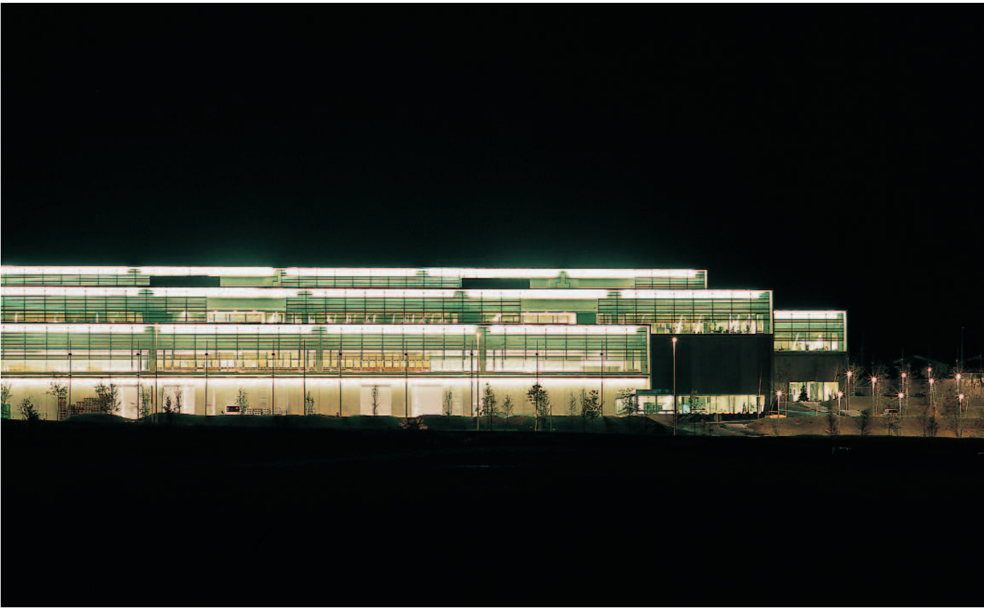
left Office Building in Barcelona (Spain) / above: Ericsson BTC in Tecnological Park, Derio (Vizcaya) izquierda Edificio de Oficinas en Barcelona (España) / arriba Ericsson BTC en Parque Tecnológico, Derio (Vizcaya)
