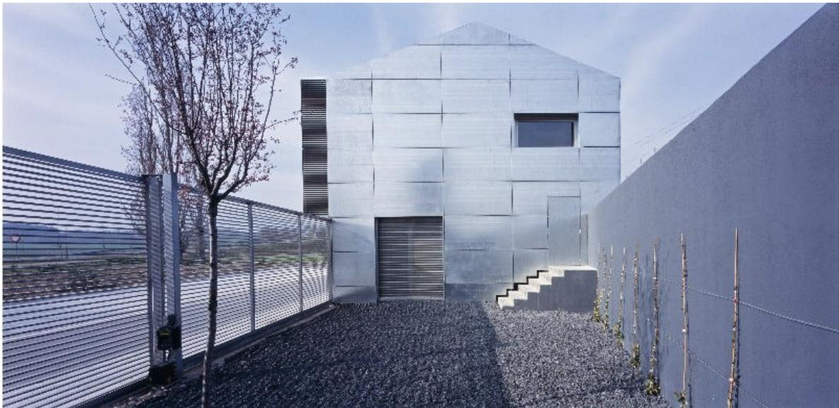
Este carácter de elemento volumétrico abstracto se manifiesta especialmente en el tratamiento de los huecos de la fachada que se agrupan bajo la piel metálica exterior en grandes huecos horizontales que se abren mediante elementos móviles, dejando a la vista las ventanas existentes de la fachada interior más relacionadas con la escala y el uso cotidiano y permitiendo desde el interior disfrutar de las magníficas vistas del entorno, especialmente desde la planta superior.
